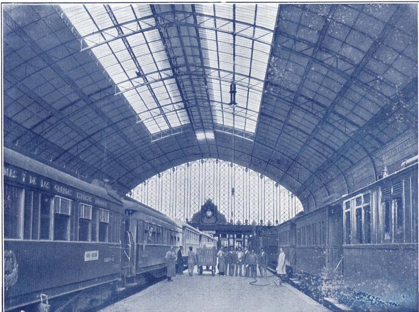
Estación de Atocha de la Compañía de FF. de M. Z. A. Cubierta antigua sustituida por «ECLIPSE» (1.500 m<sup>2</sup>.)
