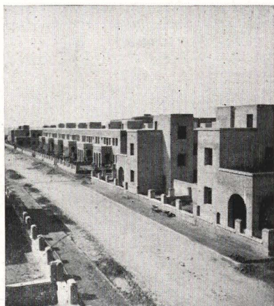
Obras de la Ciudad Jardín. Bloques de viviendas de la calle 1.
