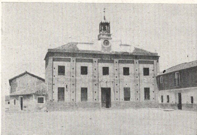
Estado en que se encontraba el Ayuntamiento al hacerse cargo de las obras el I. N. C.
