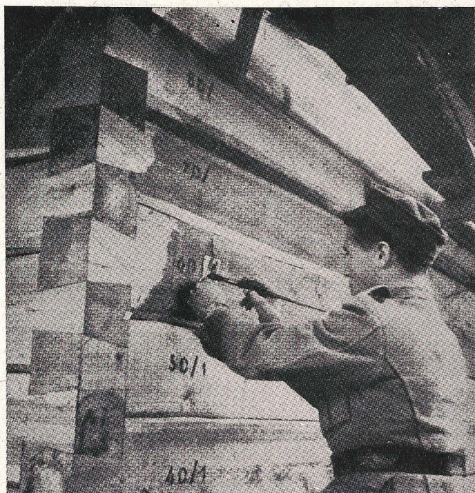
Las piezas de la casa son numeradas en el bosque, antes de separarlas para su envío al emplazamiento definitivo.
