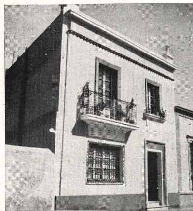
Casa en la calle Terriza.
