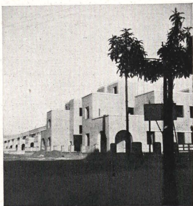
Obras de la Ciudad Jardín. Bloques de la carretera de la Marina.
