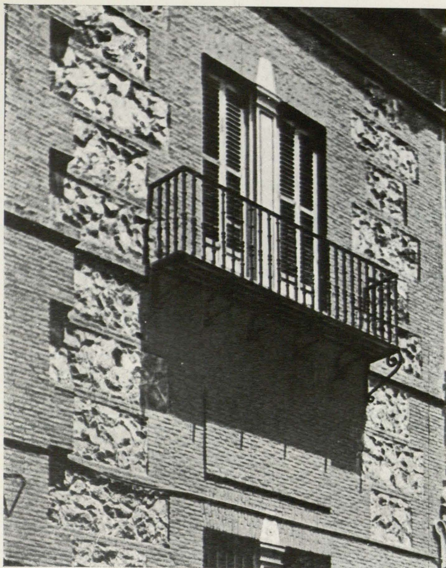
Fábrica de ladrillo y mampostería en la Casa de las Siete Chimeneas, de Madrid.
