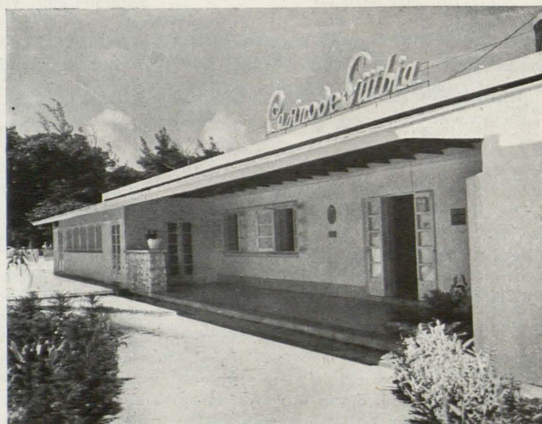
Casino de Güibía. Arquitectos J. A. Caro, G. González y B. Martínez. Ciudad Trujillo.
