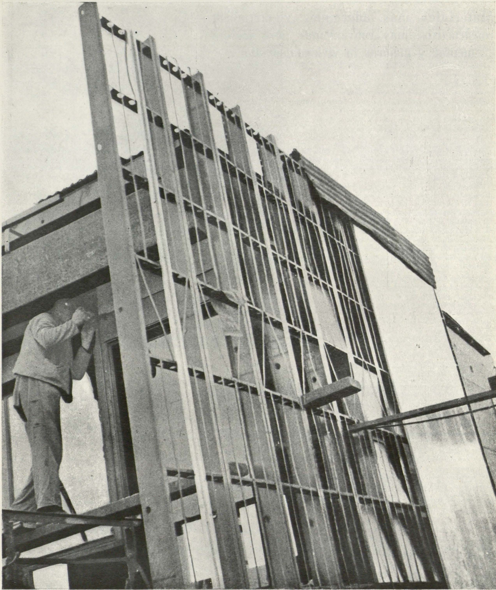
Montaje de viviendas prefabricadas de aluminio. Francia.
