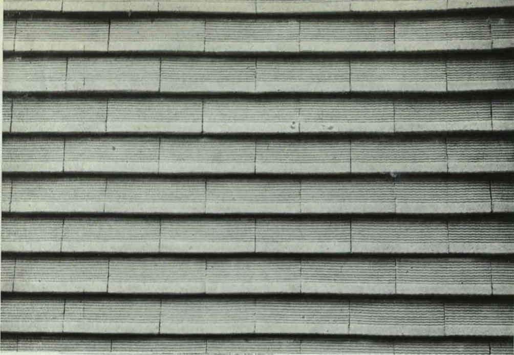
*Detalle de un paramento hecho con ladrillo especial para cerramientos.*
