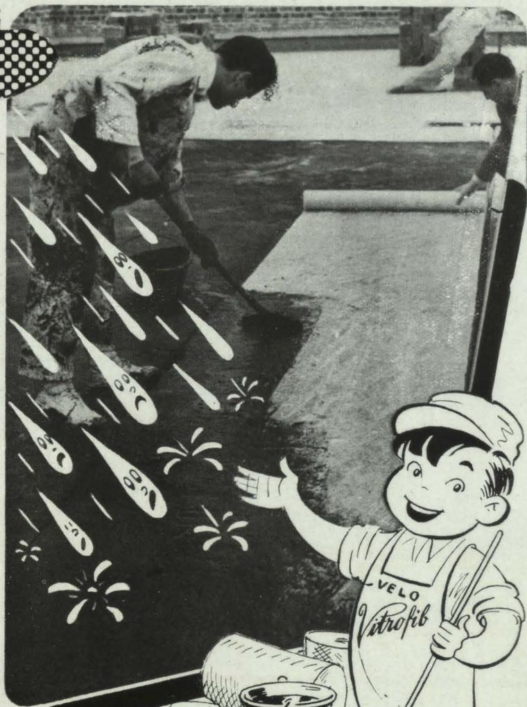
Detalle de la impregnación con emulsión asfáltica del VELO VITROFIB, en una terraza
