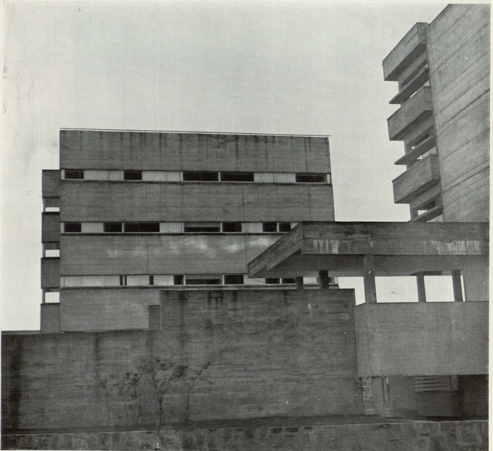
LA RAMPA DE ACCESO A LA GALERIA DEL BLOQUE PRIMERO EN EL FRENTES MAS ALTO DEL TERRENO.
