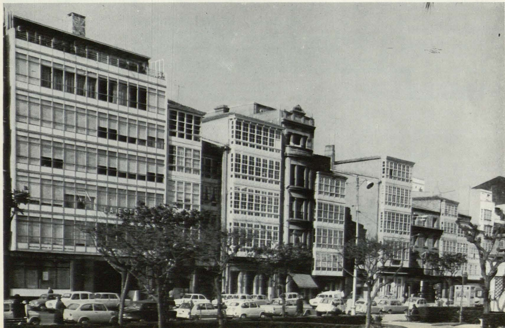
FACHADA A LA AVENIDA DE LA MARINA.
