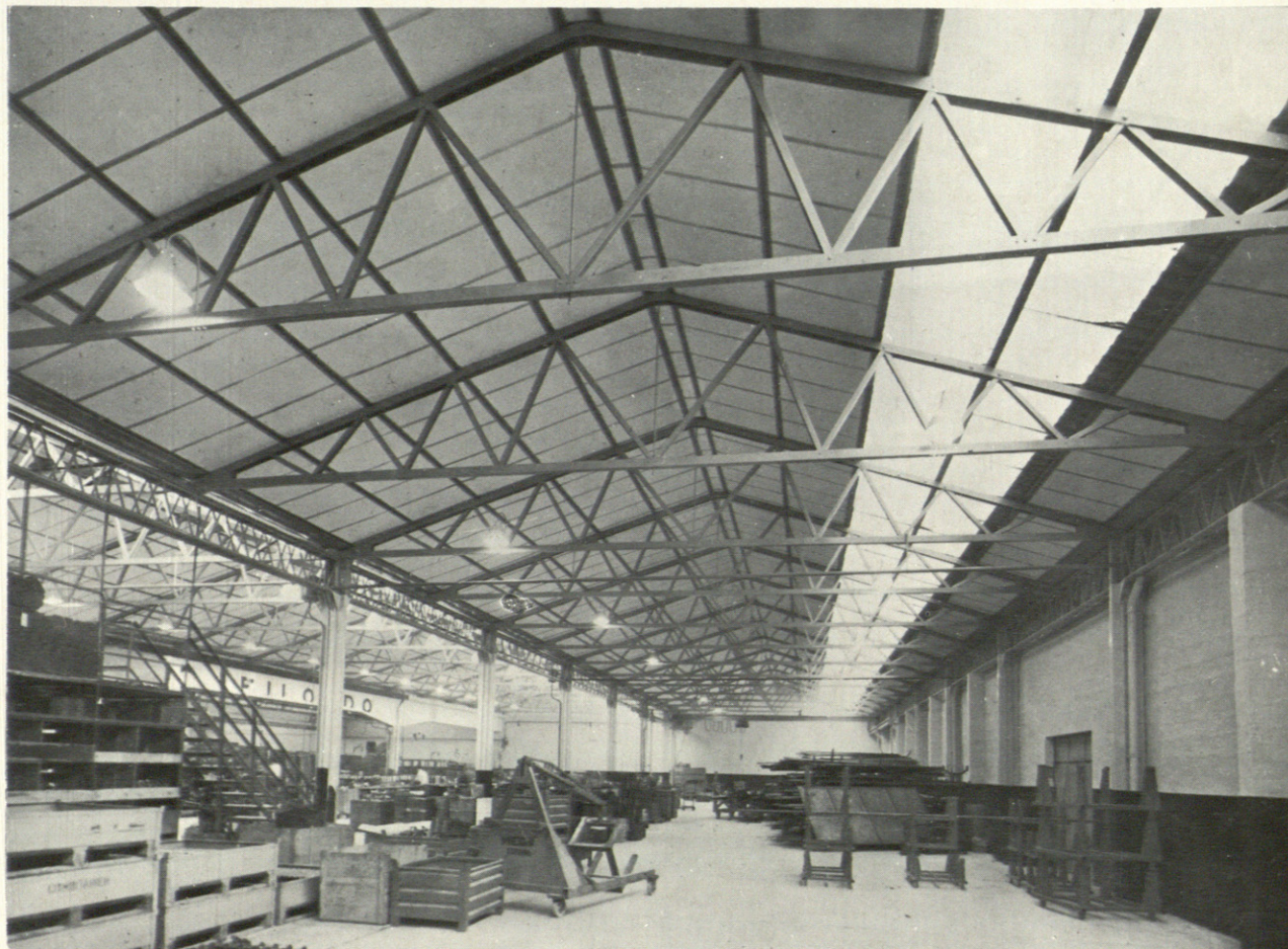
Nave industrial en Berriz-Olacueta (Vizcaya), propiedad de D. Melchor Gabilondo. Material empleado: Panel Decorativo Industrial (1.800 m. 2 ). Instalador: C. de Zavala e Hijos, S.A. (Bilbao).
