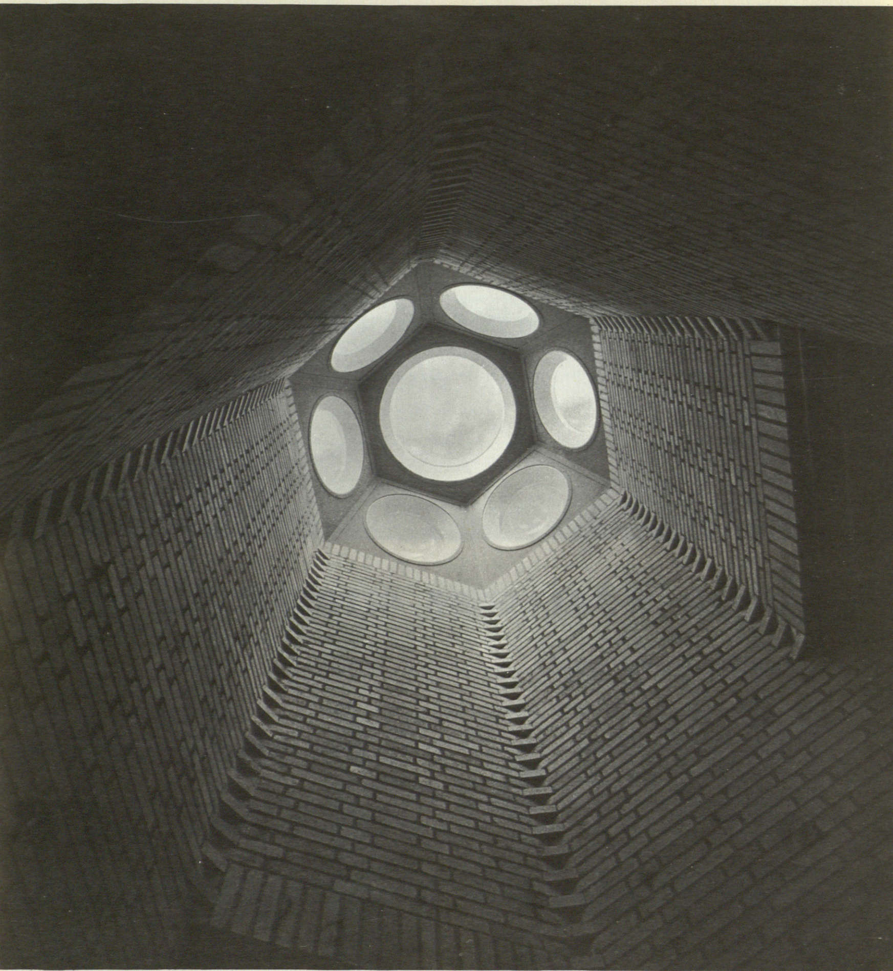
Pormenores del interior y exterior del Colegio Los Negrals en Alpedrete
