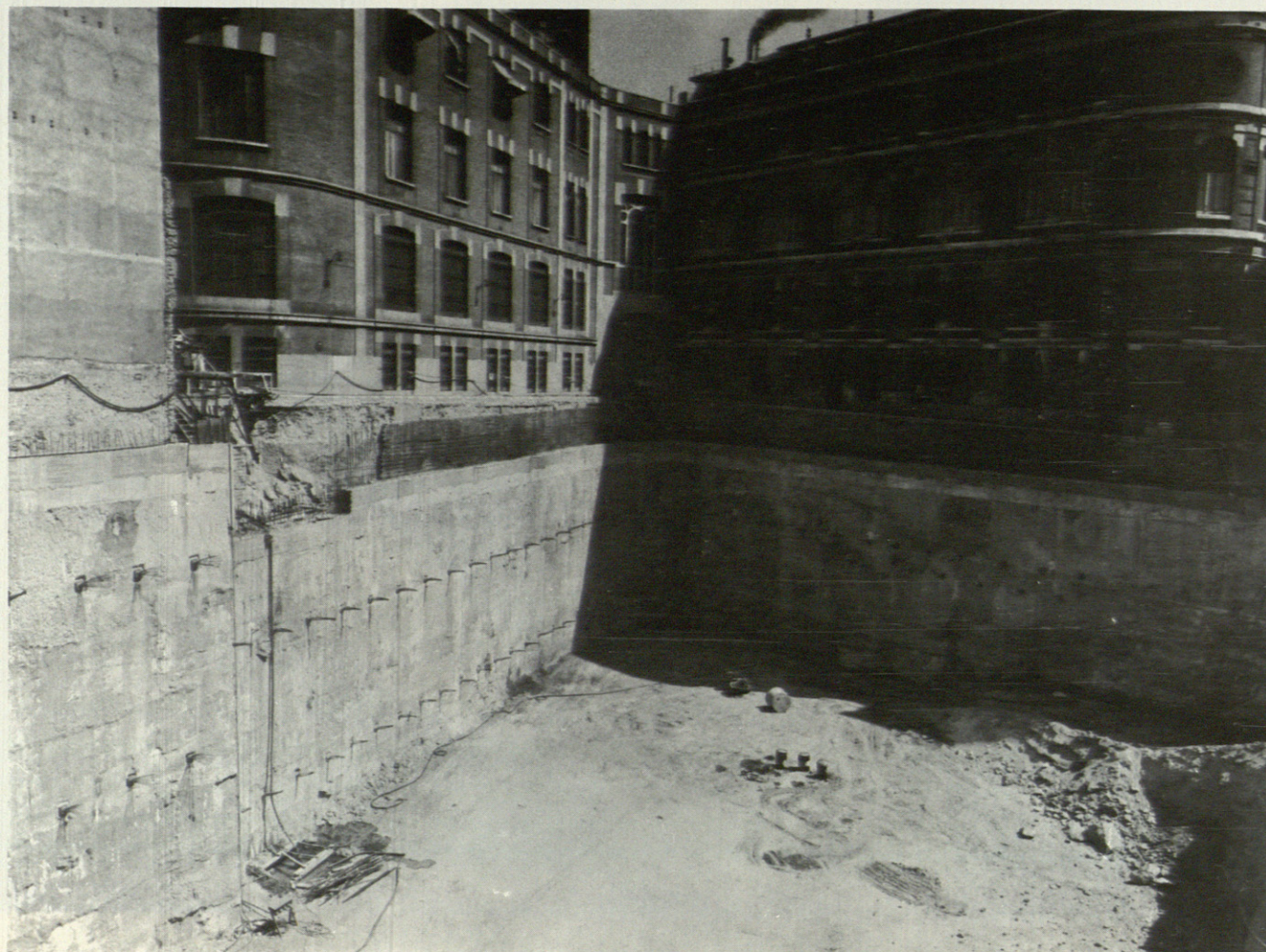
OBRAS DE AMPLIACION DEL EDIFICIO DEL BANCO DE ESPAÑA - MADRID Pantalla continua
