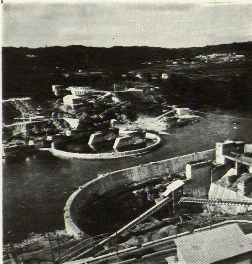
ATAGUIAS POR INYECCION EN EL SALTO DE VELLE (RIO MIÑO), PARA FENOSA
