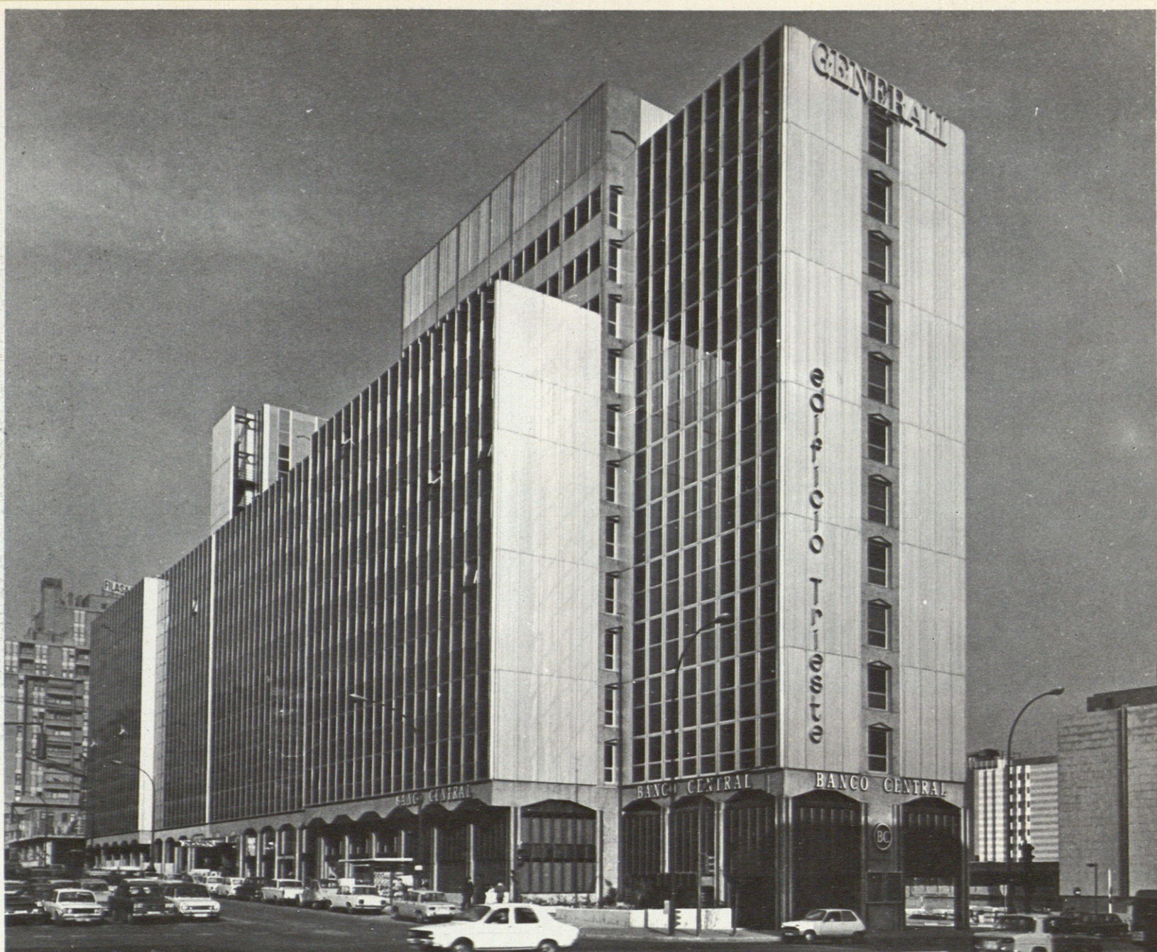
Aspecto del edificio desde la calle Raimundo Fernández Villaverde
