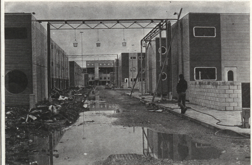
Una de las calles de circulación rodada.
