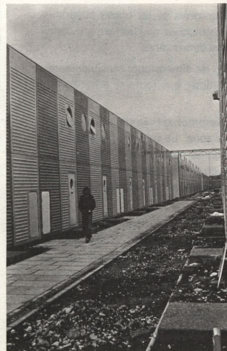
Paneles de G.R.P. que sirven de cerramiento en fachada principal en los corredores de los bloques de hormigón de la primera fase.
