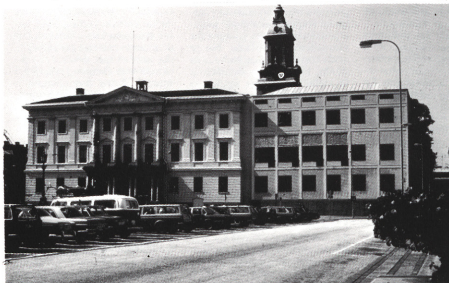
La Ampliación construida. Foto H. Johansson.
