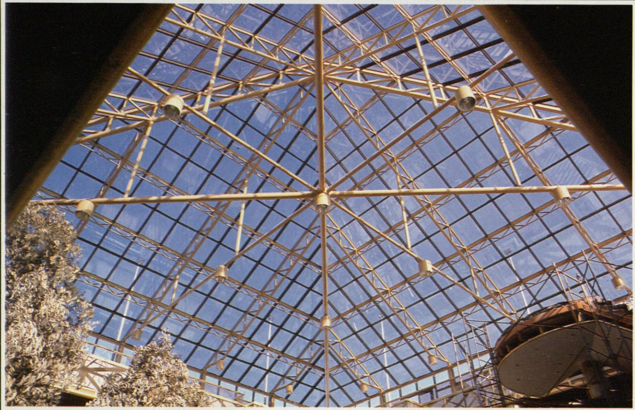
Los perfiles patentados Hiberlux en aluminio constituyen la armadura portante y mantienen el acristalamiento. Una junta en neopreno mantiene el aislamiento térmico. El perfil posee canales para drenar el agua de condensación.
